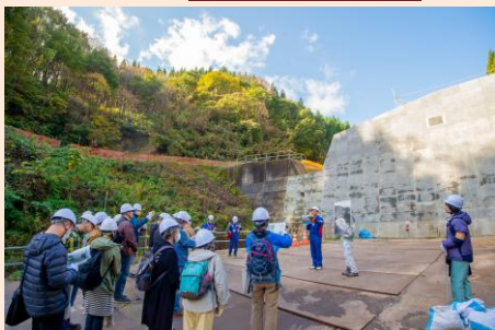
改築中(当時)の下土沢砂防堰堤は、令和4年8月の災害で効果を発揮。
