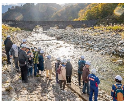
玉川スーパー暗渠砂防堰堤
