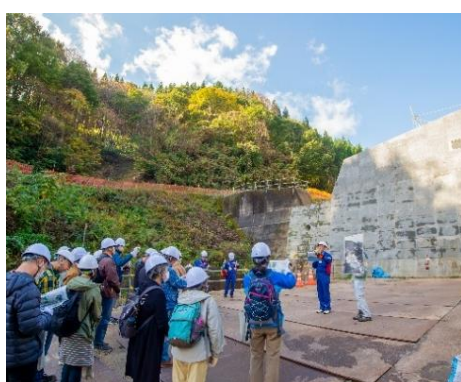
下土沢砂防堰堤
