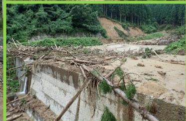
昨年8月の大雨後、下土沢砂防堰堤での現地見学は今回で3回目となります。堆積した土砂・流木の撤去はほぼ完了しました。
