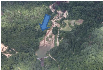
綱川第2号砂防堰堤(小国町)
