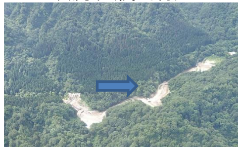
藤沢川第3号砂防堰堤(関川村)
