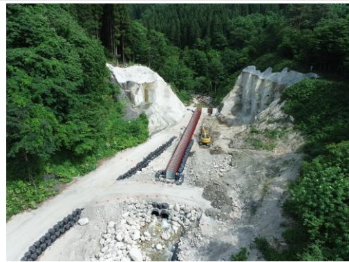
藤沢川第3号砂防堰堤施工状況
