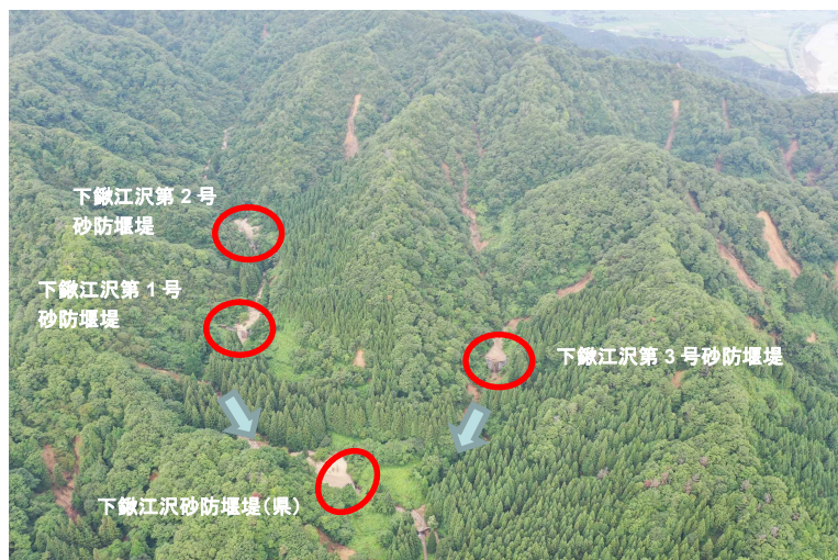
下鍬江沢砂防堰堤群（新潟県胎内市、岩船郡関川村）
