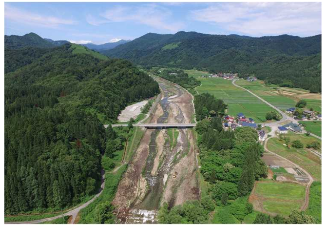
荒川流路工(荒川流路工補修工事現場)
