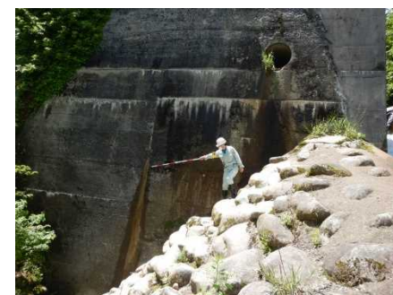
砂防施設の巡視点検(令和3年5月31日)
