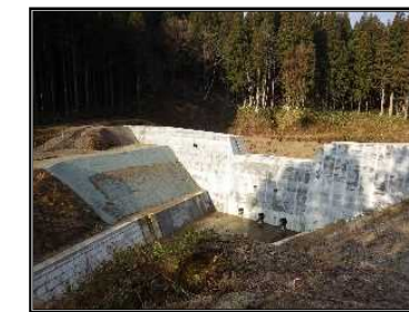
日光沢砂防堰堤
