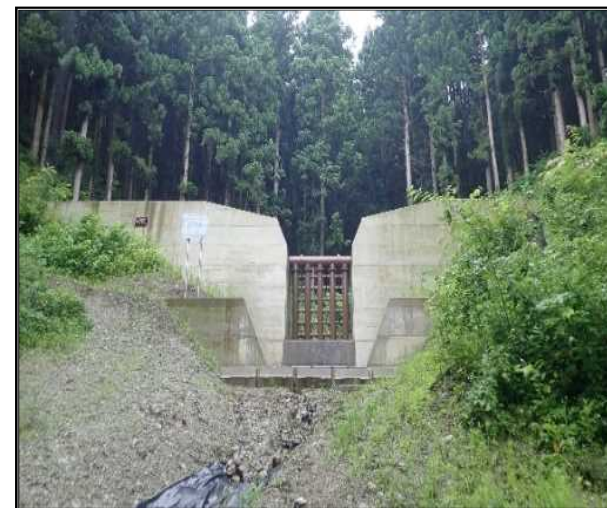
松岡沢砂防堰堤
