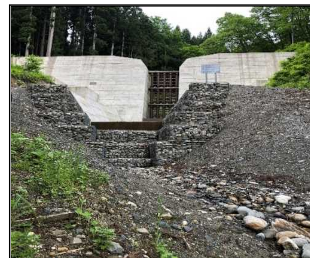
裏堀沢砂防堰堤
