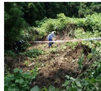
↑ 上流で確認された法面崩壊
