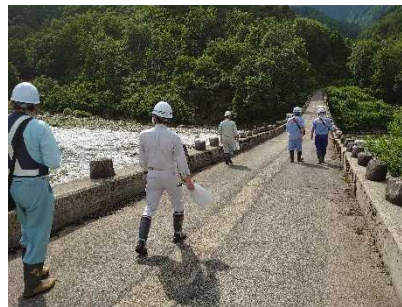
玉川スーパー暗渠砂防堰堤 点検状況
