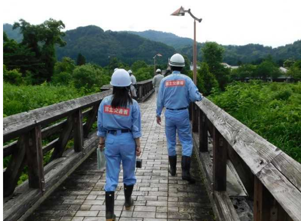
荒川流路工付近（かじか橋） 点検状況
