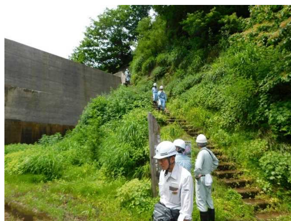
梅花皮沢第4号砂防堰堤付近 点検状況
