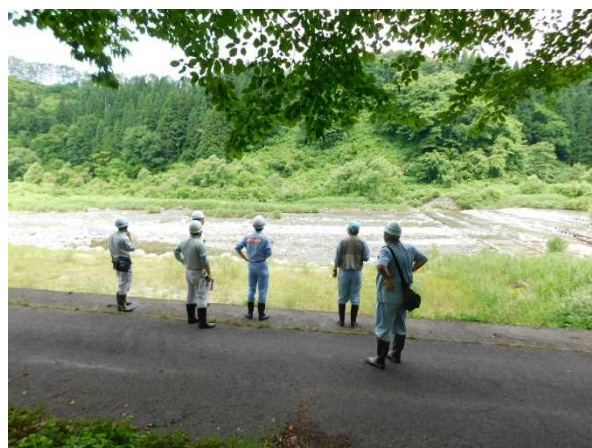
荒川流路工 点検状況
