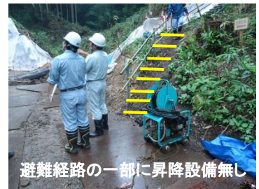
発電機周辺に消火器無し
