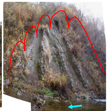
大規模崩壊斜面状況
