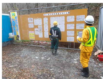
中ノ俣川砂防堰堤 （表示の点検）
