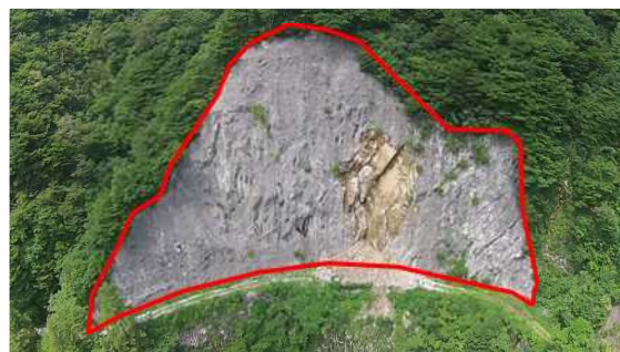
斜面崩壊状況
