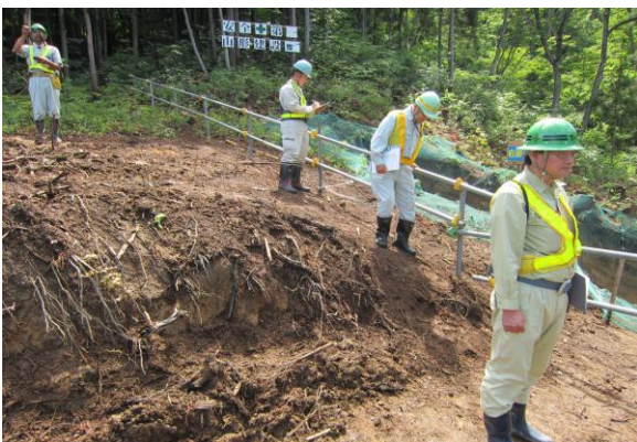
安全点検状況
