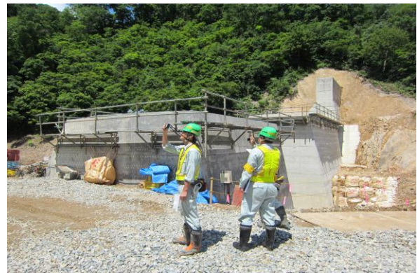
安全点検状況
