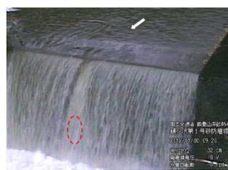
増水により流速が速くなり、越流水が水車を飛び越える
