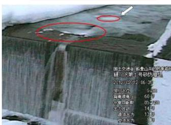
雪塊が呑み口部(切欠き部)に詰まり、越流水の流れを乱している
