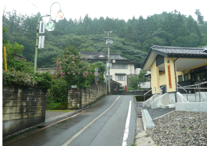
羽越水害土砂災害被災箇所 関川村湯沢地区の状況
