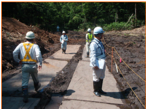
現地安全点検状況
