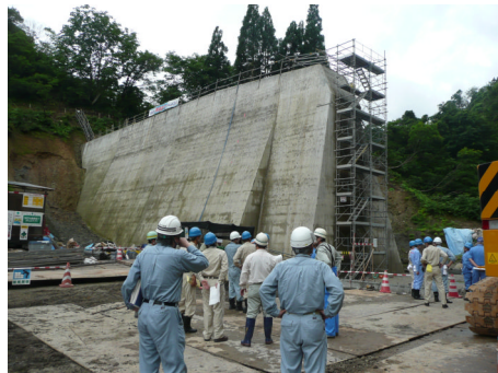
平成22年度合同巡視の様子 (入山第2号砂防堰堤)
