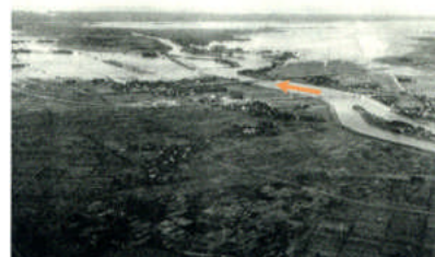
昭和42年羽越災害で加治川が破堤し多大な被害を受けた新発田市(昭和42年羽越災害時の写真)
