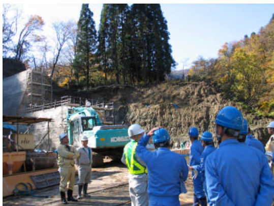
入山第2号砂防堰堤の現場にて地山やコンクリート打設状況を確認
