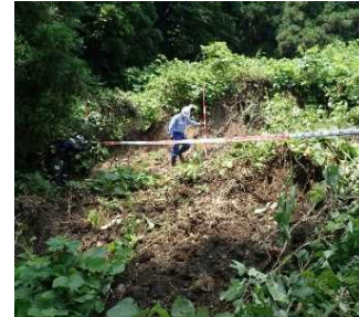
↑ 上流で確認された法面崩壊
