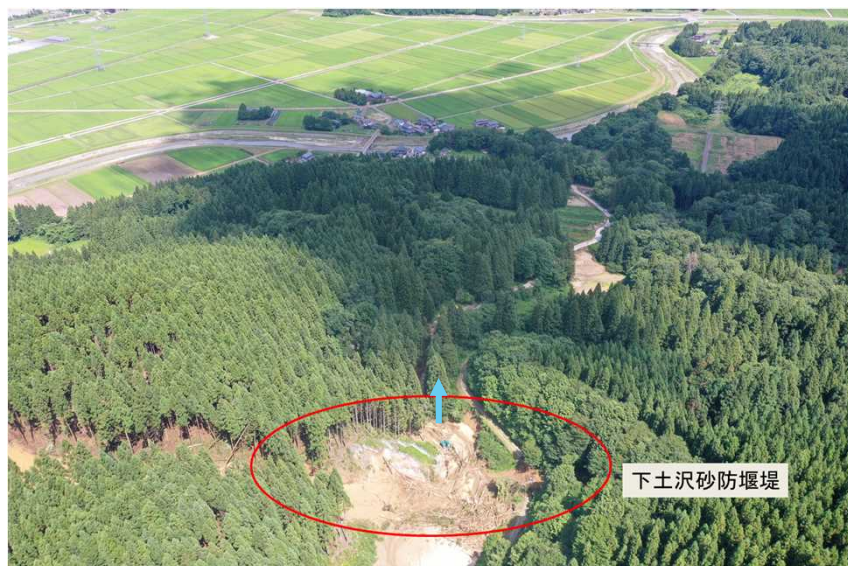
下土沢砂防堰堤が土砂・流木を捕捉、土石流による被害を防止
