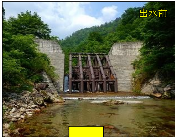
明沢川第3号砂防堰堤
