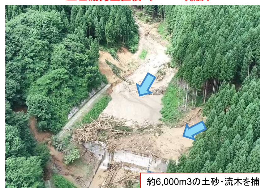
土石流発生直後 (R4.8.4撮影)
