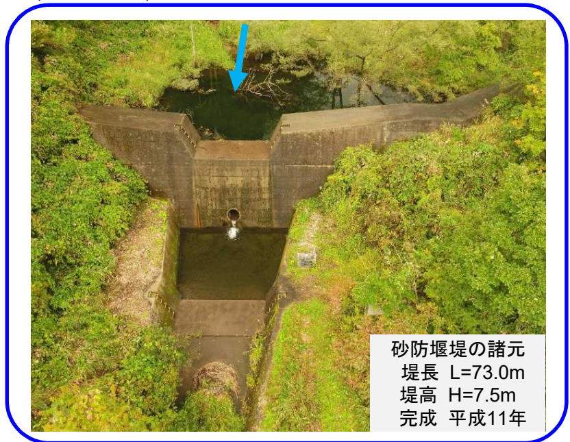
土石流発生前 (R3.10.26)
