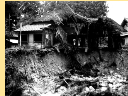
民家の基礎部分が根こそぎ流出
