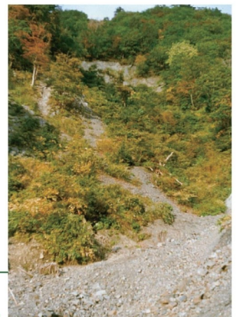
斜面の崩落(胎内川流域中流部)
