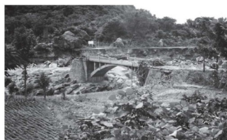
河川は削られ、樽ヶ橋も破壊された(胎内市下赤谷)
