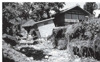
新発田市溝足地区の土砂災害
