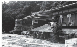
大量の土砂で建物の1階部分が埋まる(関川村湯沢)
