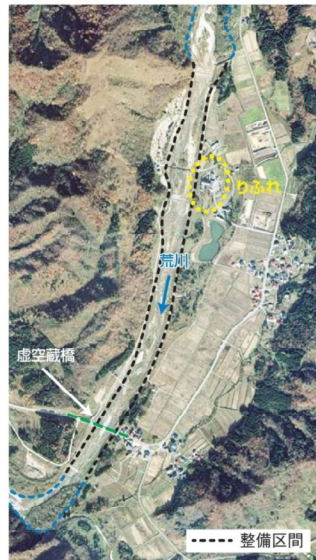
荒川流路工全景（平成18年撮影）
