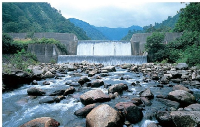
梅花皮沢第4号砂防堰堤 (小国町)
