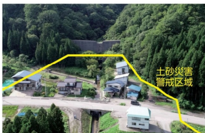
七助沢砂防堰堤 (小国町)
