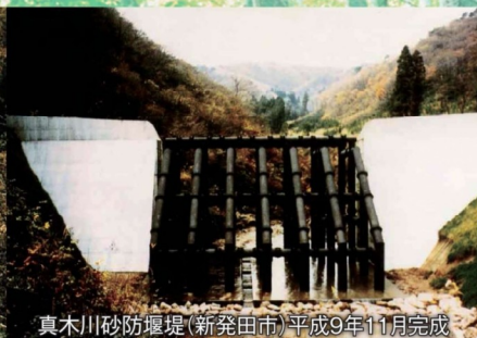
真木川砂防堰堤(新潟田市)平成9年11月完成
