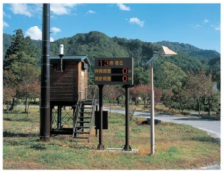
雨量計・雨量観測局舎
