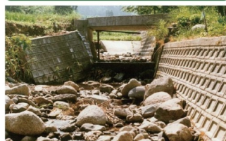
豪雨による土砂流出(加治川流域坂井川上流支川)
