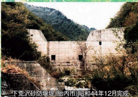
下荒沢砂防堰堤(胎内市)昭和44年12月完成
