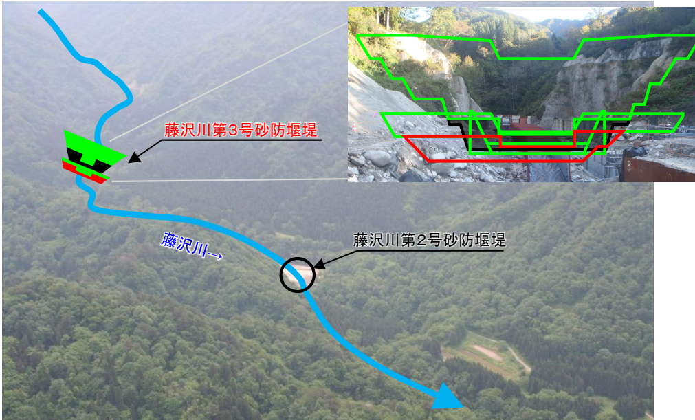
藤沢川第3号砂防堰堤 (岩船郡関川村中東地先)
