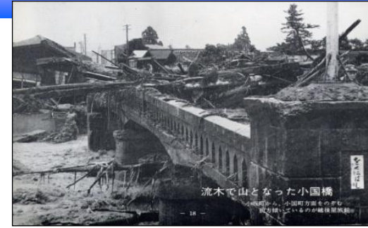
流木の山となった小国橋 S42.8 小国町小坂町(中心街) 「おおみず(小国町)」より
