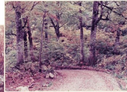
ブナの伐採を避けた 工事用道路
