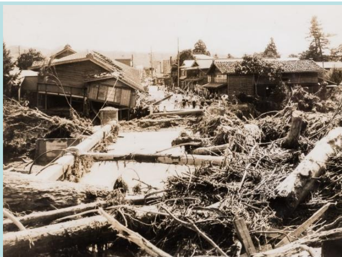
流木によって橋梁部が閉塞した事例 ※羽越水害(1967年)時の小国大橋
