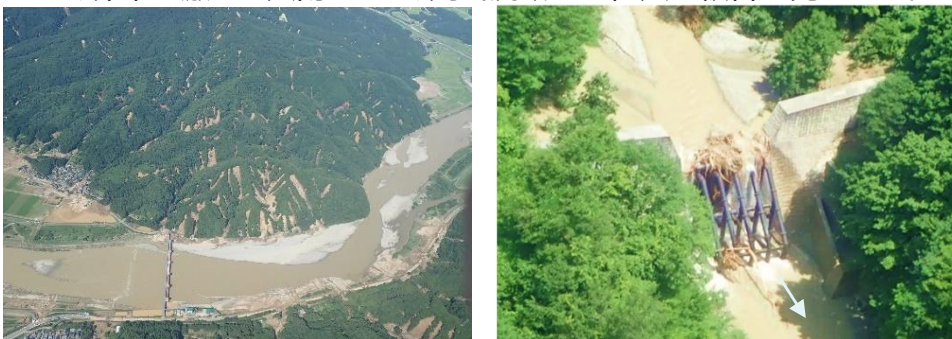
流域内において表層崩壊が多数発生 土砂及び流木を砂防堰堤が捕捉
