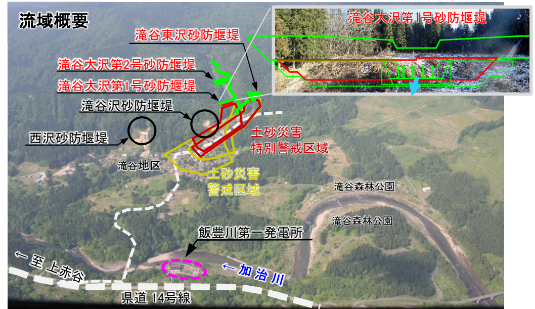
滝谷沢砂防堰堤群 (新発田市滝谷地先)
