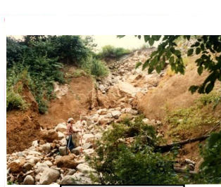
崩落の痕跡 (加治川支渓流)
