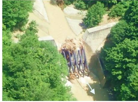
流域内において表層崩壊が多数発生 土砂及び流木を砂防堰堤が捕捉
