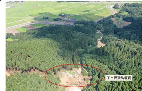
↑土砂・流木を捕捉、土石流による被害を防止
