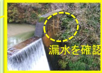
砂防点検員（作業責任者）、操縦者、操縦補助者、安全監視員を配置し、手動操作による飛行点検を実施
