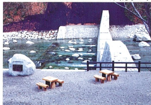
玉川上流第二号砂防ダム
