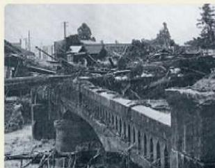
記録的な集中豪雨により上流で山崩れが発生し、大量の倒木が水と一緒に流れてくんだり、小国橋に堆積しました。/小国小坂町(横川)
