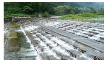
荒川流路工に設置された全断面魚道
