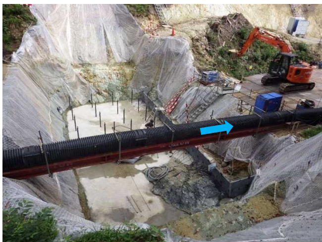
施工箇所近影(撮影R6年10月)
