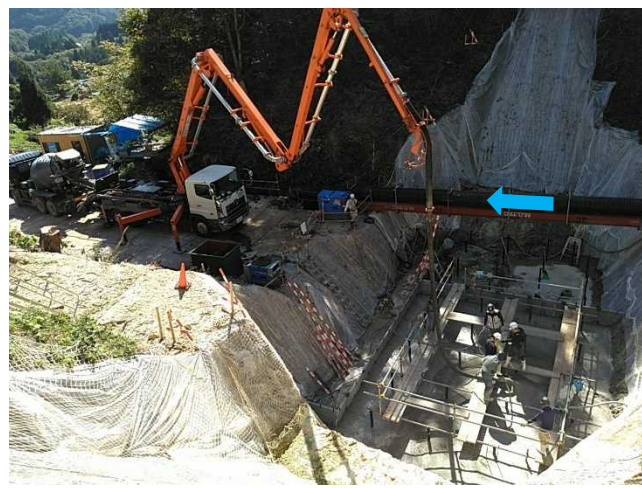
コンクリート打設状況(撮影R6年10月)
