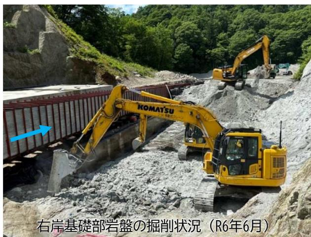
右岸基礎部岩盤の掘削状況 (R6年6月)
