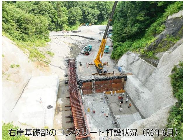
右岸基礎部のコンクリート打設状況 (R6年6月)
