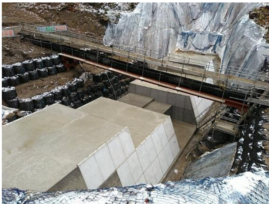
堰堤の打設状況 (堰堤ウォールを使用して施工)
