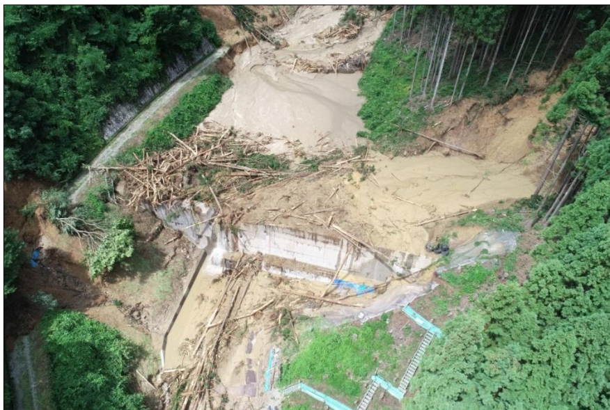
被災直後の状況
