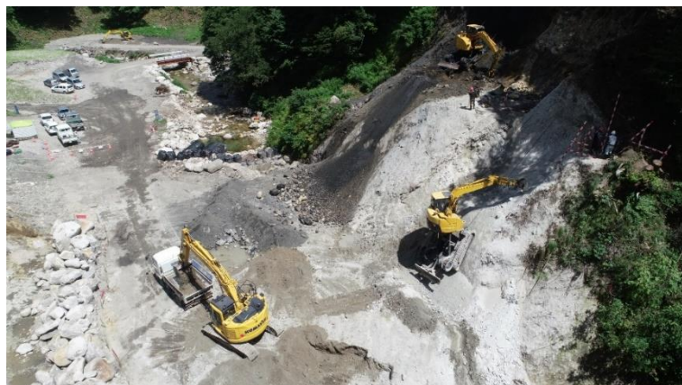
右岸側の掘削の様子
