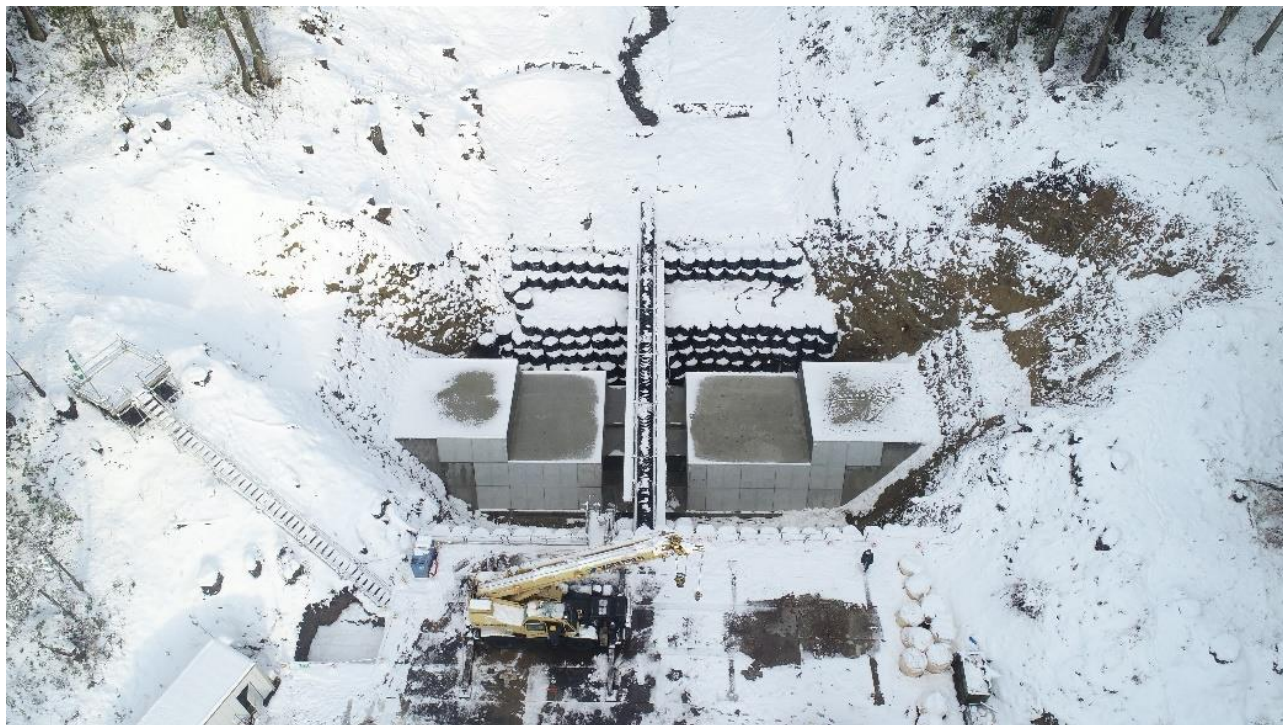
砂防堰堤施工箇所(撮影：R4年11月)
