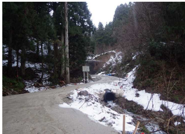
平成30年12月25日撮影 イモノマ沢砂防堰堤工事用道路盛土完了状況
