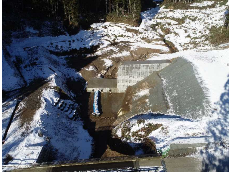
平成30年12月20日 完成状況全景
