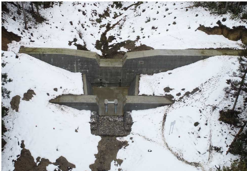
平成31年1月穴沢2号砂防堰堤完成状況
