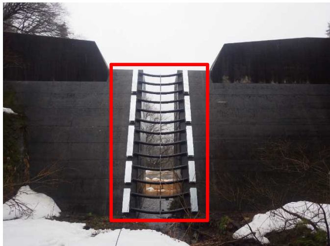
平成30年12月26日撮影 黒俣川砂防堰堤流木止め設置完了状況
