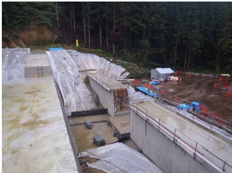
平成30年10月1日垂直壁コンクリート打設完了状況
