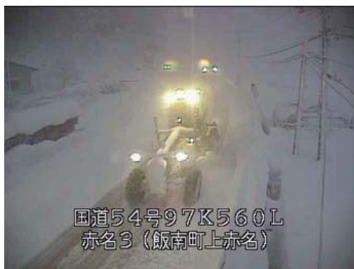
除雪作業状況
