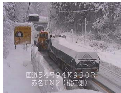
除雪車によるけん引状況
