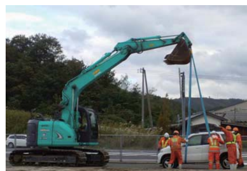
バックホウによる吊り上げ状況
