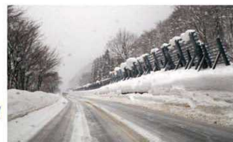
雪崩予防柵(国道17号 新潟県南魚沼郡湯沢町)
