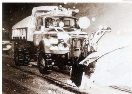
排雪板を装着した ダンプトラック
