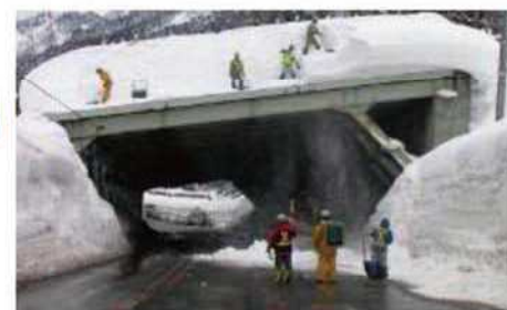
スノーシェッド(国道17号 新潟県南魚沼郡湯沢町)
