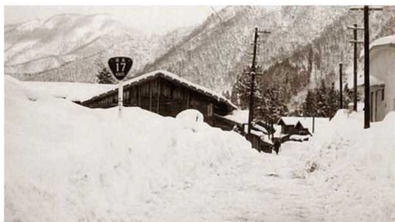
雪で埋もれた 国道 17 号
