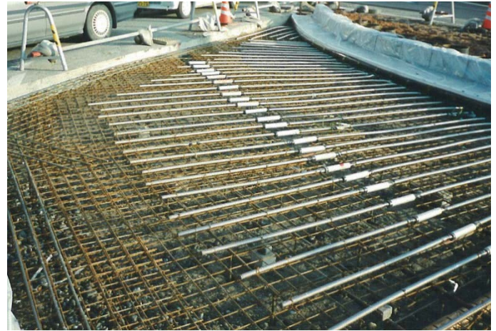
①ヒートパイプ設置状況
