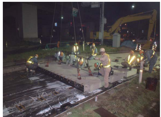
④プレキャスト舗装版施工状況
