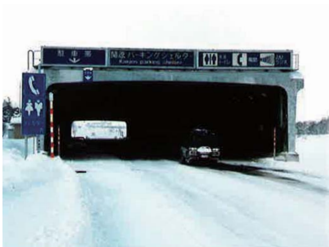
①鋼製シェルター
