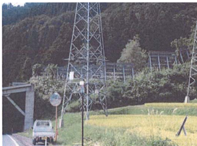
②誘導工（誘導柵）
