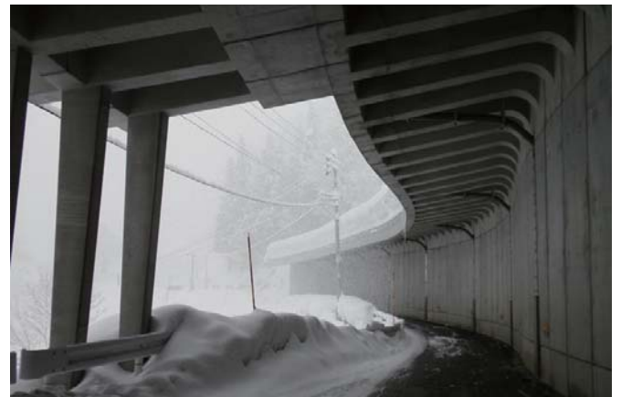
③スノーシェッド（コンクリート）
