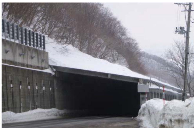
④スノーシェッド（コンクリート）
