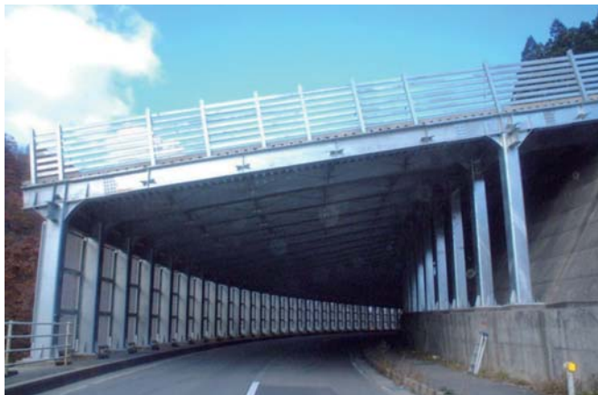
②スノーシェッド（鋼製）
