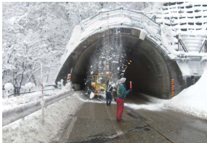
トンネル坑口の雪落とし
