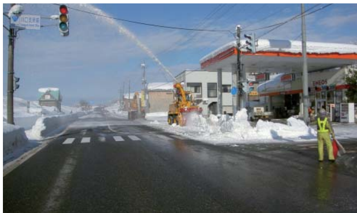
ロータリ除雪車による作業
