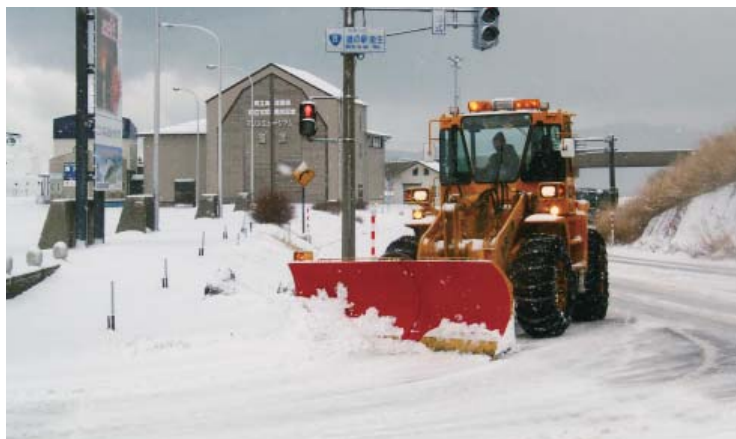
除雪ドーザによる作業
